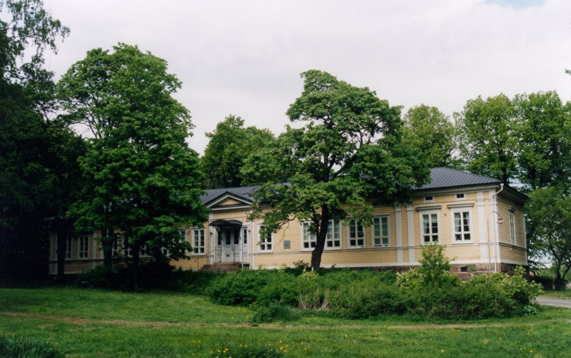
Arwidssoninkadun puurakennus toimi oppiaineen talona vuosina 1989–2015. Kuva vuodelta 2000.
