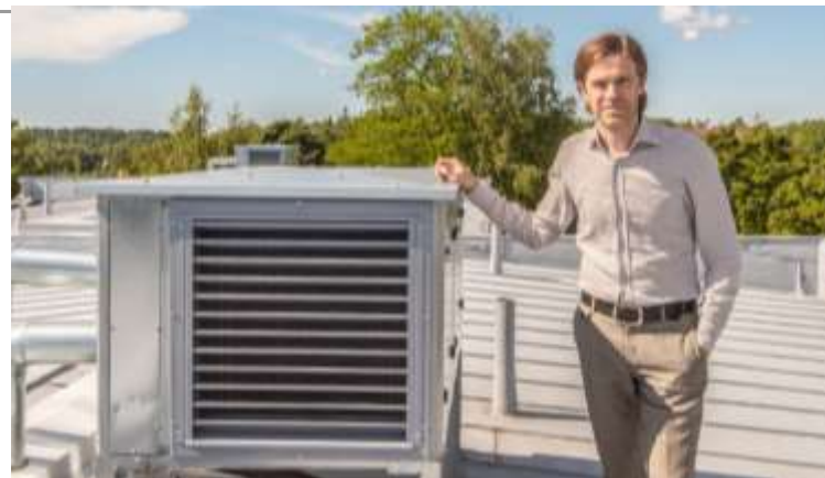
jo kertaalleen kerrostaloon hankittu ostoenergia kierrätetään poistoilmalämpöpumpulla takaisin tilojen ja käyttöveden lämmityskäyttöön
